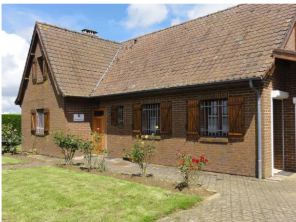
Figure 6 : Locaux administratifs de la société IKOS ENVIRONNEMENT (Source : Visite BURGEAP du 10/06/2016)
